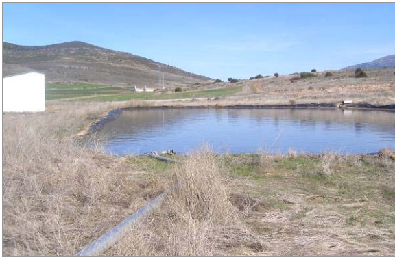
Actual tratamiento por decantación de las aguas residuales de la fabrica de patatas fritas artesanas Añavieja.
