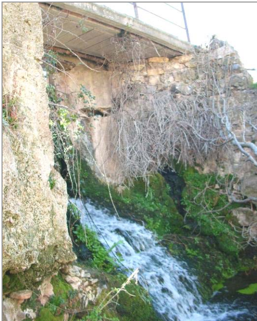
Aliviadero presa del canal de San Salvador.
