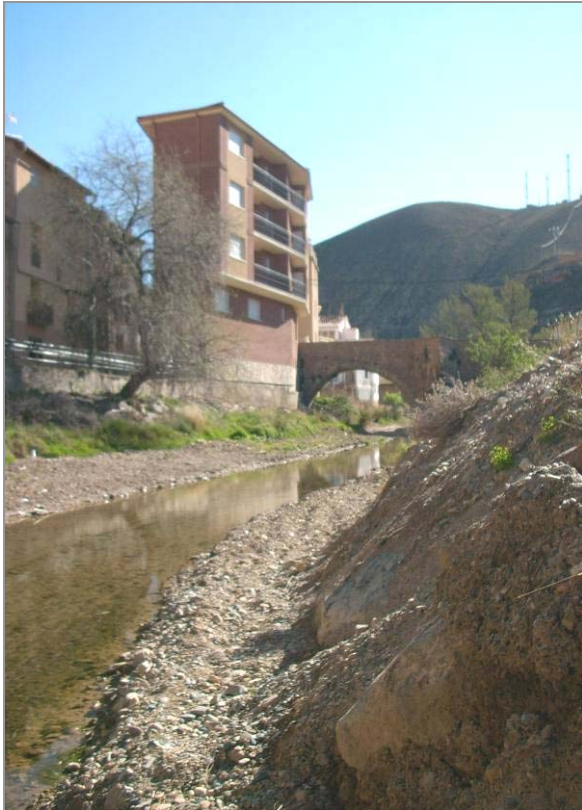
Río Alhama a su paso por Cervera. El cauce presenta una marcada curva a su paso por el casco urbano, socavando la margen izquierda, poniendo en riesgo a las edificaciones allí asentadas.
