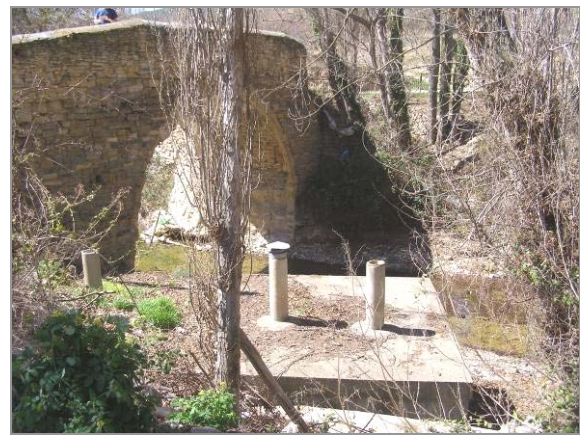
Pozo séptico de Cigudosa, localizado en la margen derecha del río Alhama
