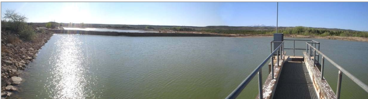
Embalse de Las Estaquillas en Cintruenigo, abastece de agua potable a los municipios de Cintruenigo, Cascante y Fitero.
