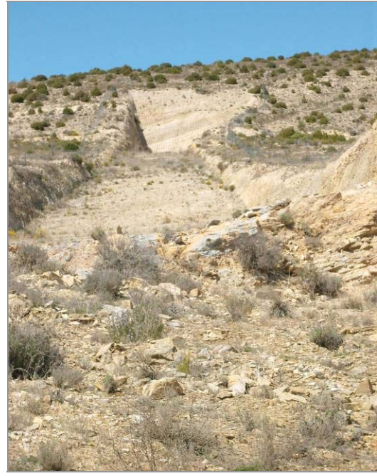
Excavación para cimientos de la presa Cigudosa-Valdeprado
