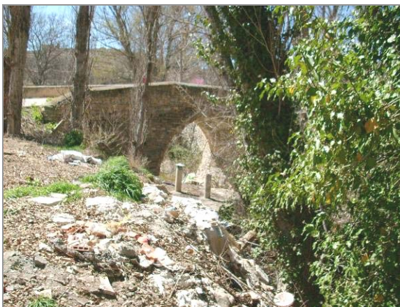
Vertedero sobre la margen derecha del río Alhama a su paso por Cigudosa
