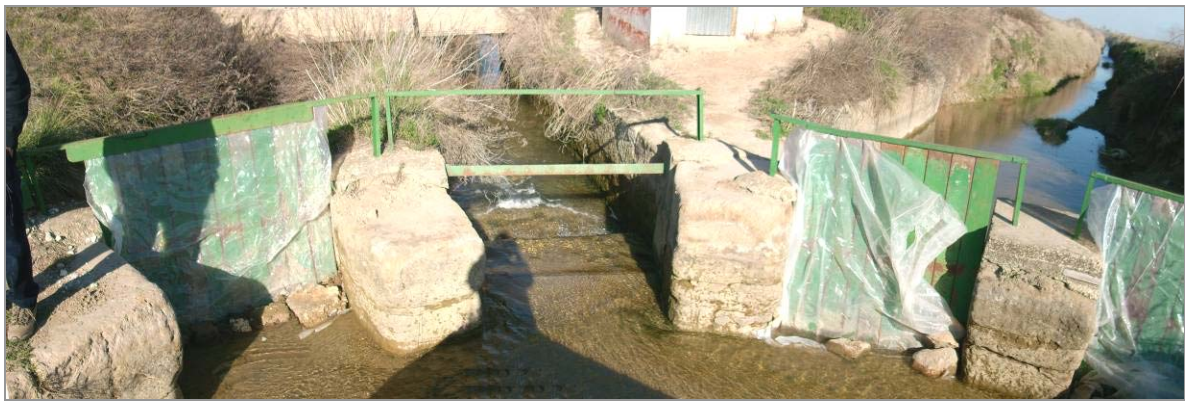
Punto de división de Los Fieles en el paraje de Las Arquetas en Cintruenigo. Desde este punto se transvasa agua del río Alhama a la balsa de Purgel, en la cuenca del Queiles.
