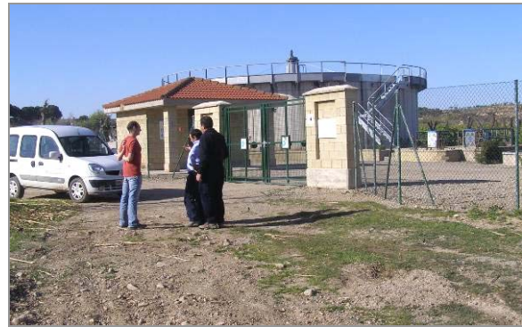
EDAR de Fitero. Tecnología aplicada lodos activados.
