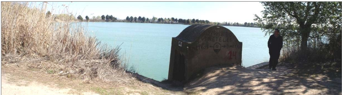
La Estanca en Corella (2 hm 3 ). Abastece a los regadíos de Corella y Alfaro. Alimentada con aguas del río Alhama por la acequia de Cañete, esta incluida en el inventario de zonas húmedas de Navarra.
