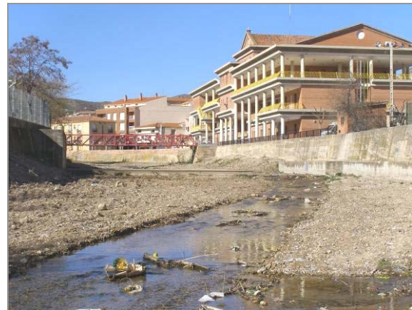
Estación de aforo 251 río Alhama en Cervera del Río Alhama
