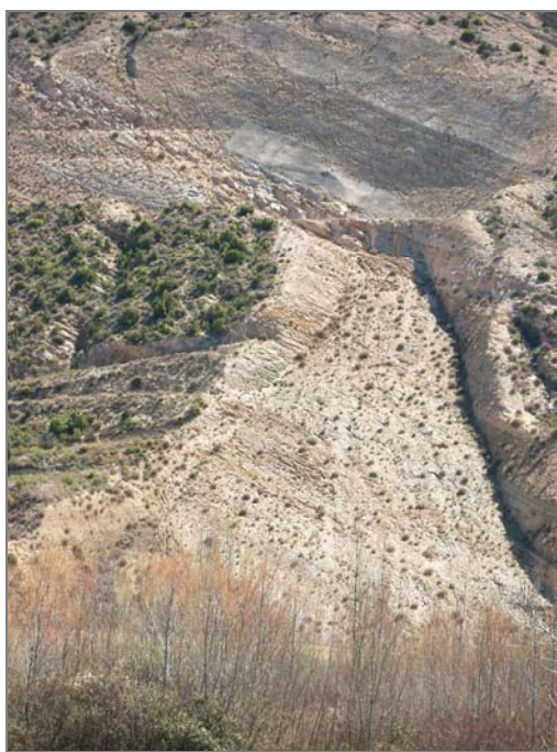
Excavación para cimentación de la presa de Cigudosa-Valdeprado. Estribo margen derecha
