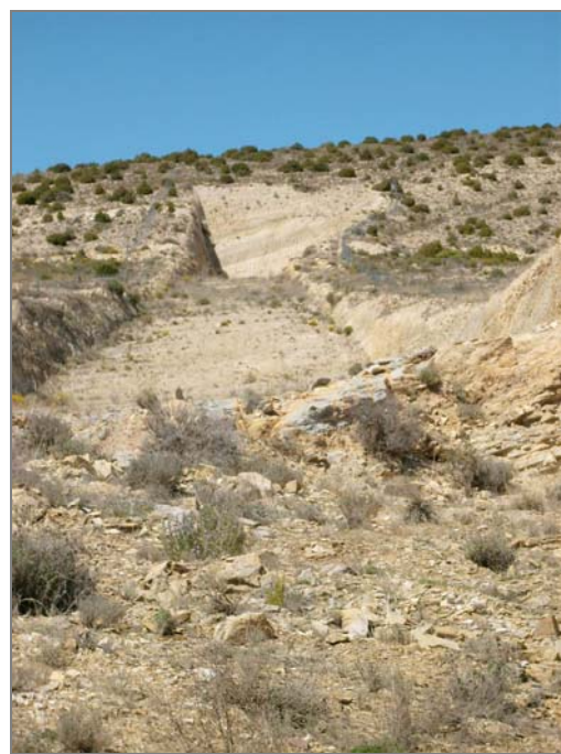
Excavación para cimentación de la presa de Cigudosa-Valdeprado. Estribo margen izquierda
