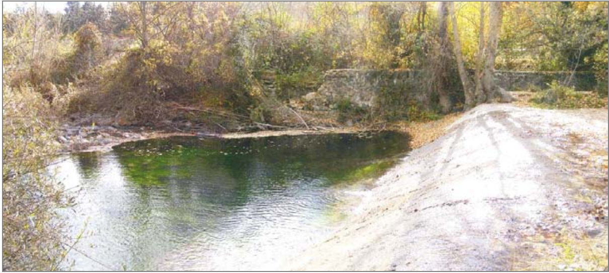
Antiguo azud de molino sobre el río Cidacos en su entrada al casco urbano de Enciso, actualmente se usa para regadío de huertas
