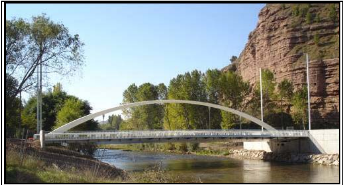
Puente “arco” / viaducto sobre el río Najerilla en la localidad de Najera
