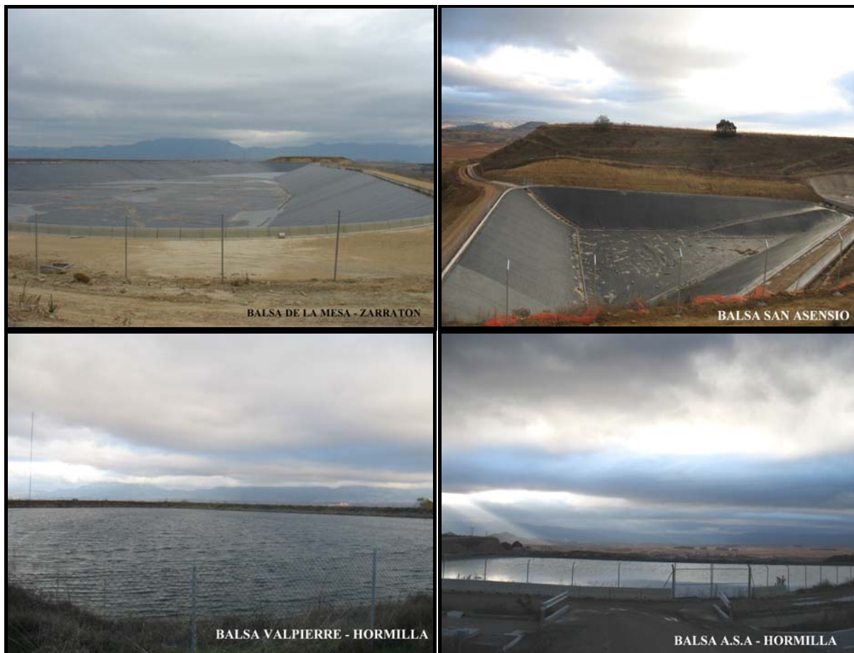
Figura 2.37: Algunas de las nuevas infraestructuras de riego construidas en el Tramo III del canal M.I. del Najerilla.
