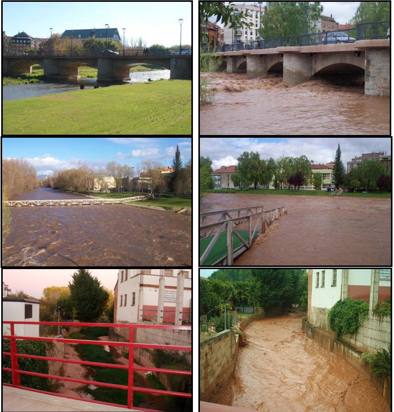
Figura 2.49: Afecciones provocadas por el río Najerilla a su paso por Nájera, y el río Yuso en la localidad de Arenzana de Abajo (mayo de 2.003)
