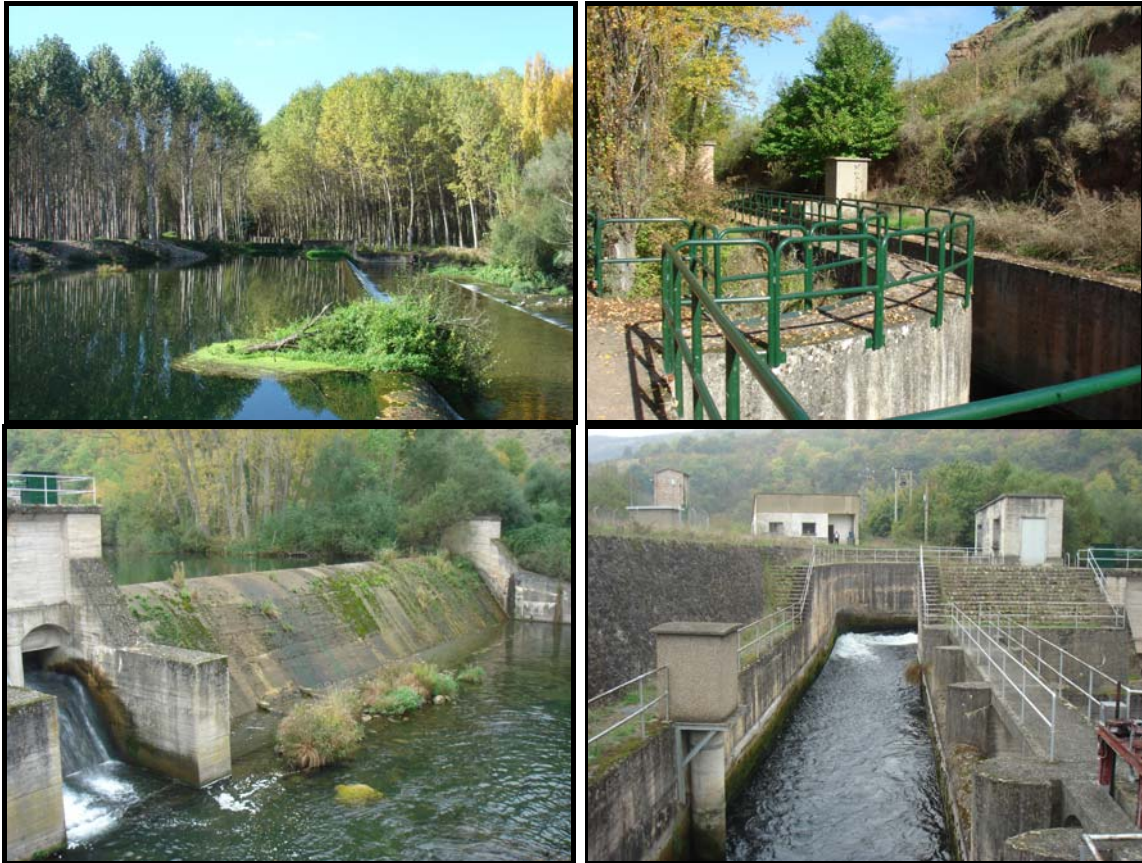
Figura 2.49: Azudes y tomas respectivamente de los canales de la margen derecha e izquierda del Najerilla (noviembre 2.007).
