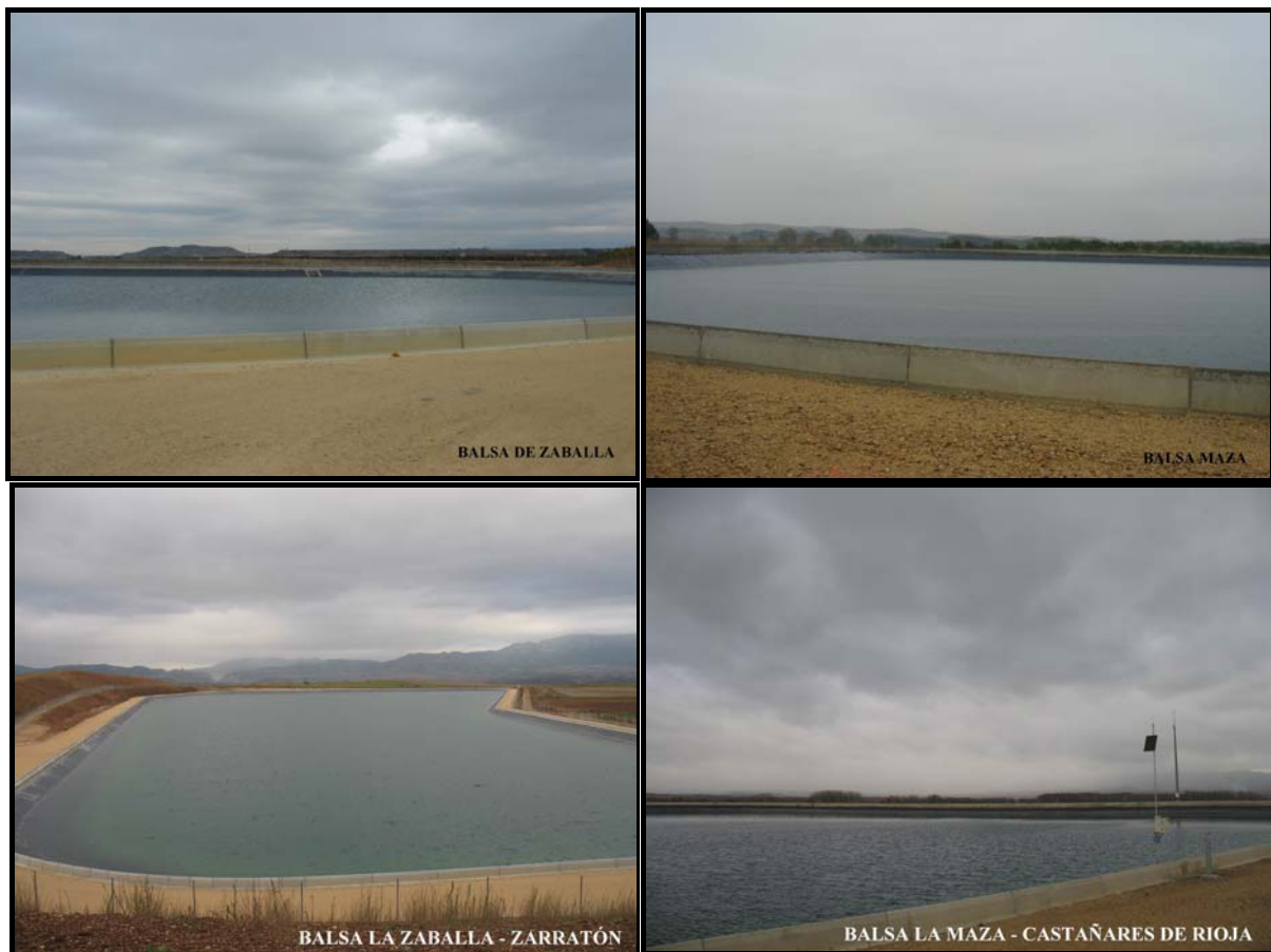
Figura 2.37 (continuación): Algunas de las nuevas infraestructuras de riego construidas en el Tramo III del canal M.I. del Najerilla.
