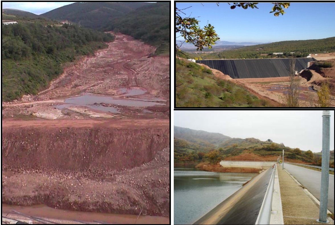
Figura 2.48: Embalse de Yalde o Castroviejo, inicio de las obras de construcción de la presa y nivel de la lámina de agua en noviembre de 2.007.
