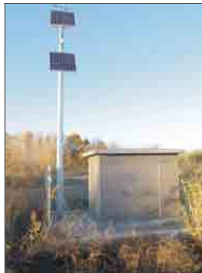
Estación de aforo de la CHE en la acequia Madre de la Comunidad General de Regadíos de Calahorra
