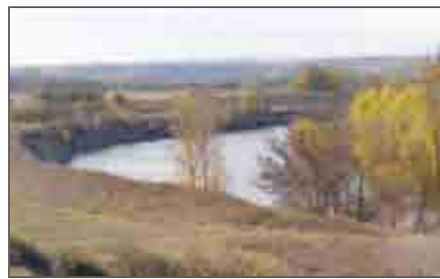
Escollera y mota construida en los años 60's sobre la margen izquierda en paraje La Mejana (Tauste), la fuerza del río durante las crecidas la vence inundando la ribera en avenidas ordinarias. En este punto se puede plantear una actuación de mejora de la capacidad de desagüe en la margen derecha y una revegetación en la margen izquierda.
