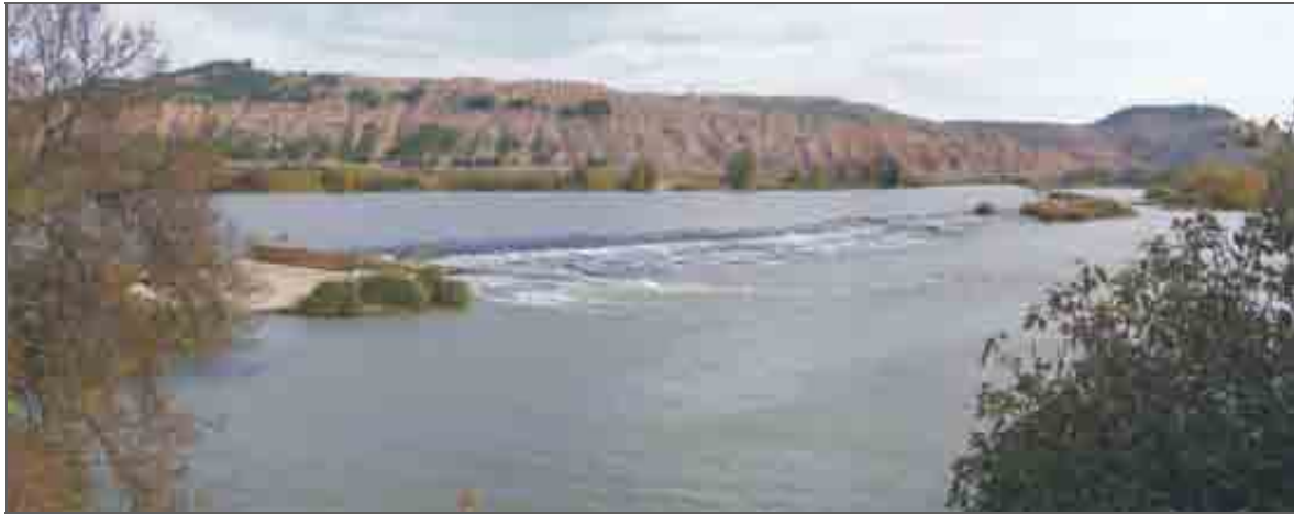
Presa de la Mejana de Mosquera, deriva las aguas del canal de Tauste en el termino de municipal de Fontella
