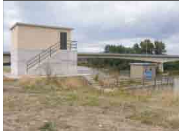
Estación de aforo de Castejón. En verano tienen que pasar entre 40 y 50 m 3 /s para satisfacer las demandas de aguas abajo (30 m 3 /a al Canal Imperial de Aragón, 15 m 3 /s al canal de Tauste y 22 m 3 /s a detracciones del río)
