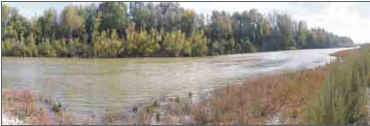
Tramo de dragados del Gobierno de Navarra en Buñuel, sacan áridos de la margen derecha y los depositan en la izquierda
