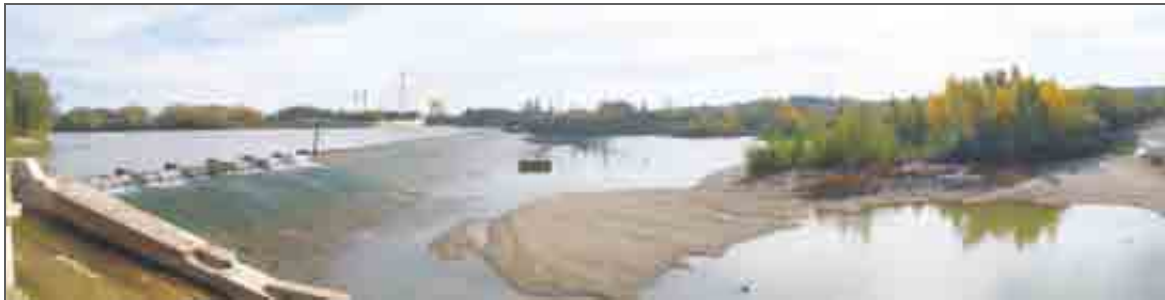
Azud de Pignatelli en El Bocal, termino municipal de Fontellas. No tiene escala de peces. En primer término, paso de almadías. De este azud sale el Canal Imperial de Aragón y en canal de la CH de Belver, con tres turbinas de 300 m 3 /s cada una. La central no turbinada en verano.
