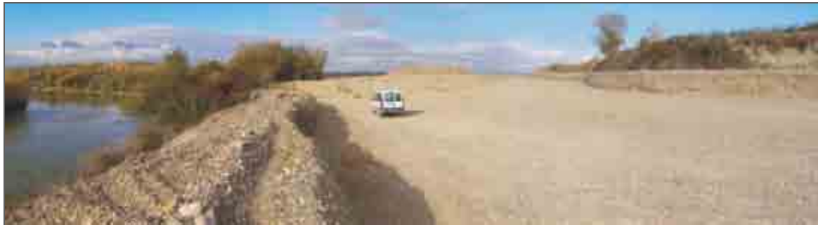
Extracción de áridos en el paraje Las Canteras en Tauste, ubicada sobre el cortado de la margen Izquierda. El río está desmontando puntualmente el talud. Cabe plantear en este punto una actuación para evitar la erosión de la margen izquierda mediante la creación de un canal de aguas altas en la margen derecha.
