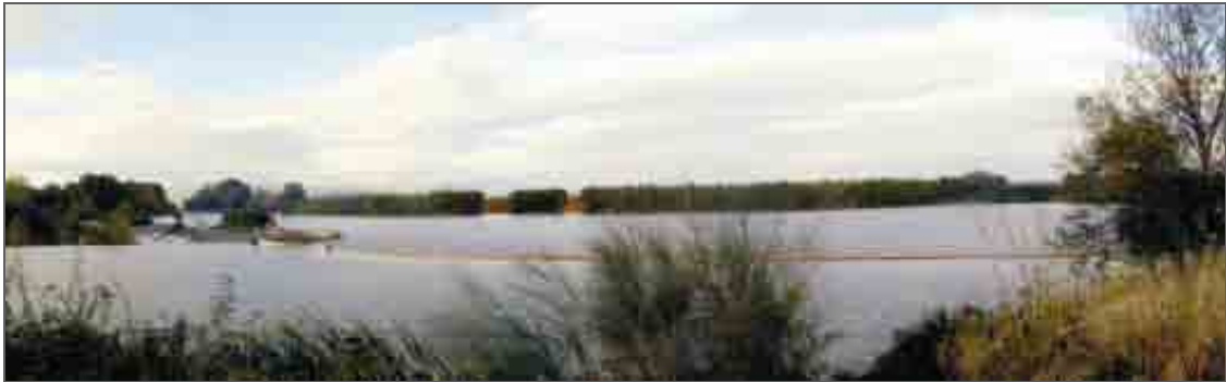
Azud de C.H de Machín y la comunidad de regantes de Ardiel y Rincón de Soto y Alfaro (en la margen derecha con un caudal de 3-4 m 3 /s) y otra acequia por la margen izquierda.
