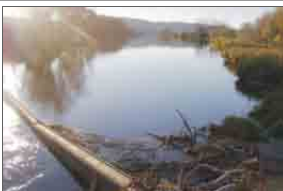
Azud de la CH de la Ribera, deriva el caudal total en verano, afectando la continuidad del río
