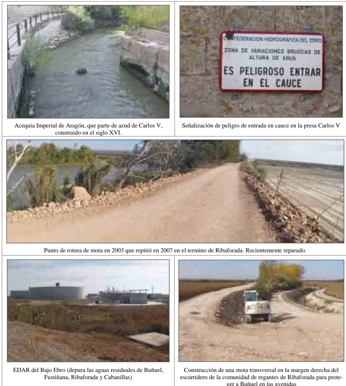
Figura 3.31: Fotos representativas de las características y problemas del eje del río Ebro desde el río Queiles hasta el río Huecha.
