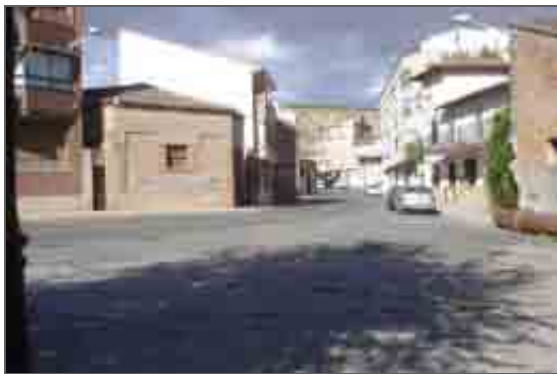
Ebro en Lodosa, punto de inundación en el 2003 hasta intersección de las calles Av. del Ebro y Paseo del Ferial
