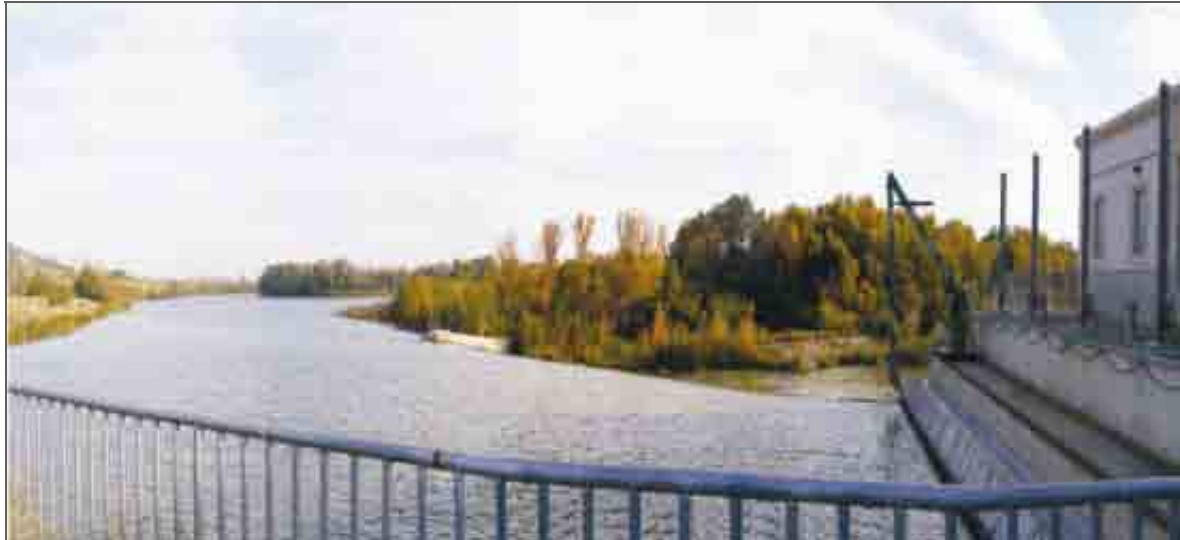
Central hidroeléctrica de Tudela y acequia de la comunidad de regantes de Arquetas, Lodares y Mosquera
