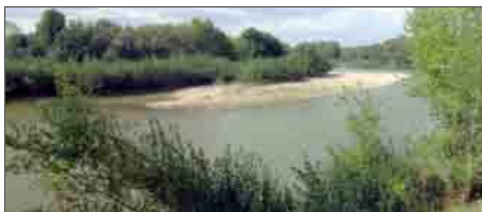
Ebro en San Adrián, el río golpea la margen izquierda socavando la escollera, mientras que en la margen derecha el río acumula gravas.
