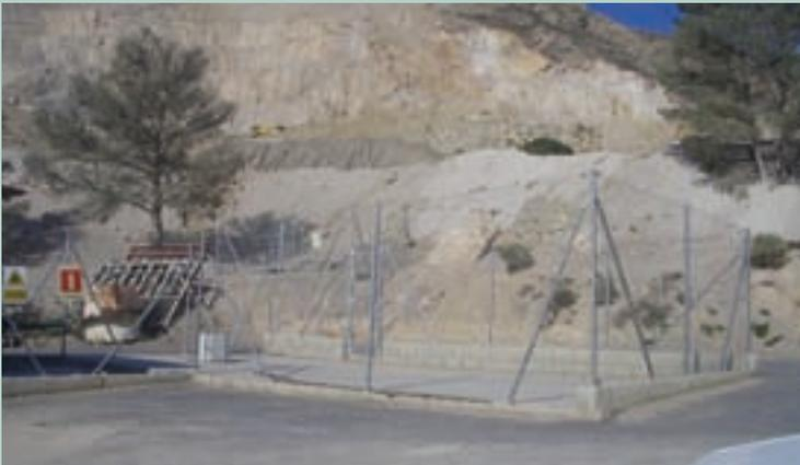
Zona de repostaje con sistema de recogida de derrames de aceites e hidrocarburos. Esta zona debe estar asfaltada para proteger, asimismo, el suelo de la posible contaminación
