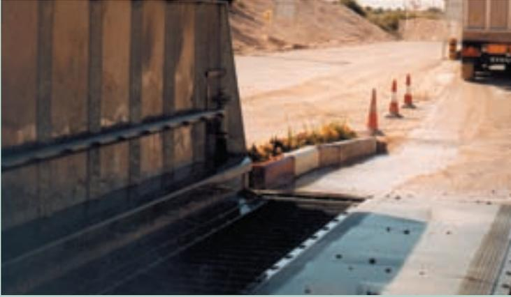
Dispositivo para el lavado de camiones con recogida del agua sucia y sistema de separación de hidrocarburos
