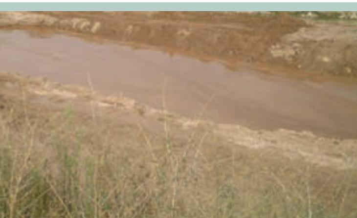
Balsa de lodos. Los sólidos se depositan y las aguas claras retornan al circuito de lavado de arenas
