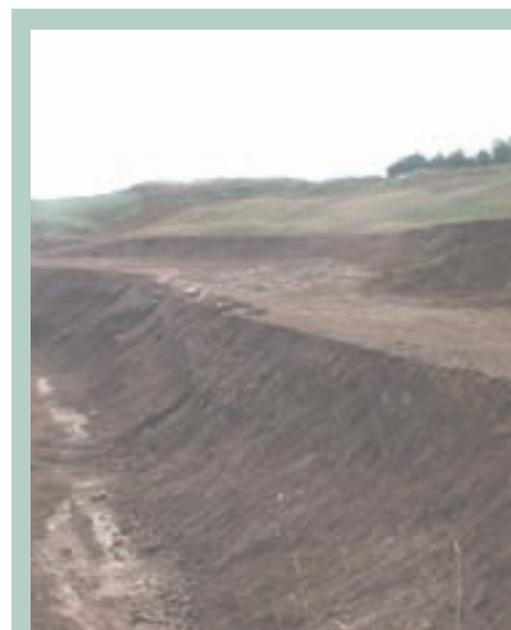
Perfil de los bancos de una explotación a cielo abierto
