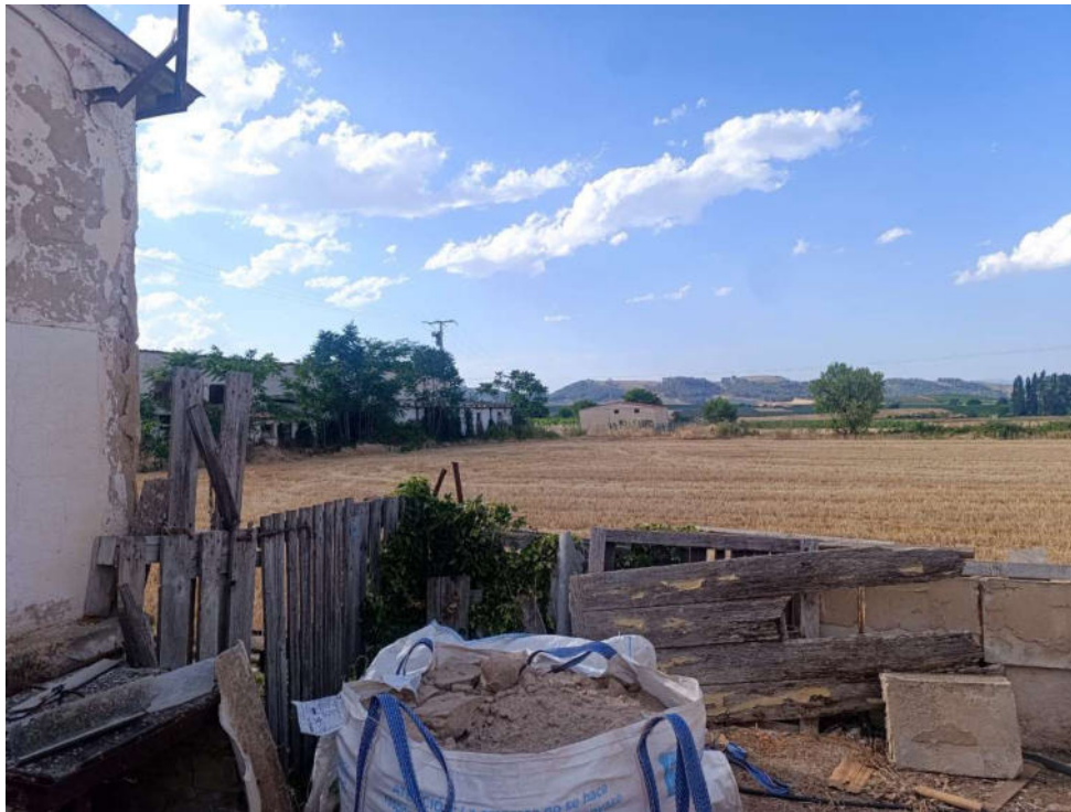
Imagen 10. Zona en la que se inicia el lado corto de la L del vallado
