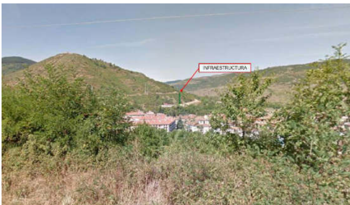
Se muestra la vista final del eje de apreciación de la unidad/recurso e infraestructura desde el punto analizado. De acuerdo con la cuenca visual y las simulaciones, la infraestructura resulta visible en el horizonte, por lo que impacta sobre la escena del paisaje.
