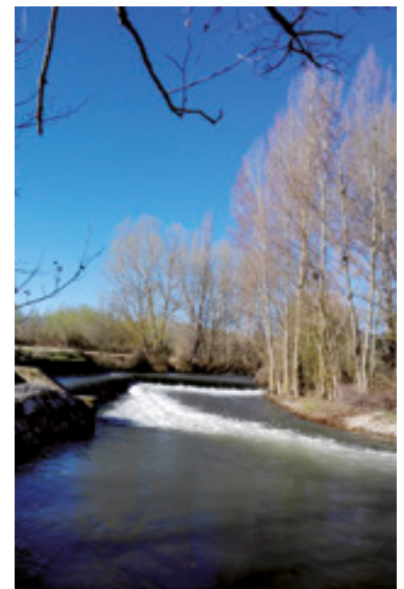
Toma de agua de la acequia de Acedas.
