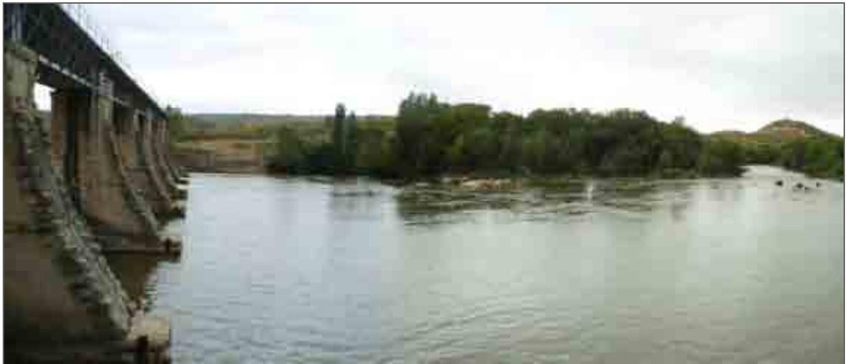
Azud central hidroeléctrica de El Cortijo. En algunas ocasiones se han producido quejas por deficiencia de caudal aguas abajo de la central . Esta central funciona a saltos, alterando el régimen del río aguas abajo de la misma. La modulación de caudal que produce la central se llega a percibir hasta Castejón. Recientemente el SAIH ha instalado una estación de aforo en el canal.
