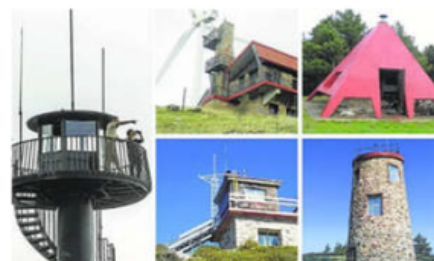
Diferentes instalaciones de vigilancia de incendios forestales.
