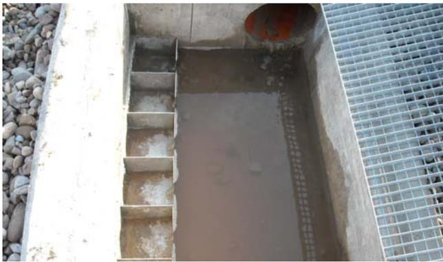
El efluente de la fosa séptica se conduce hasta la parcela donde está situado el humedal, a unos 215 metros de distancia, mediante una tubería de PVC de 315 mm de diámetro
