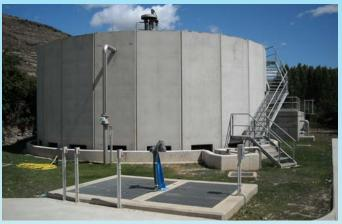
Desde el lecho, el agua pasa al decantador secundario, de planta cuadrada de 5,50 m de lado y 4,0 m de profundidad, donde se separa el agua de la materia en suspensión.
