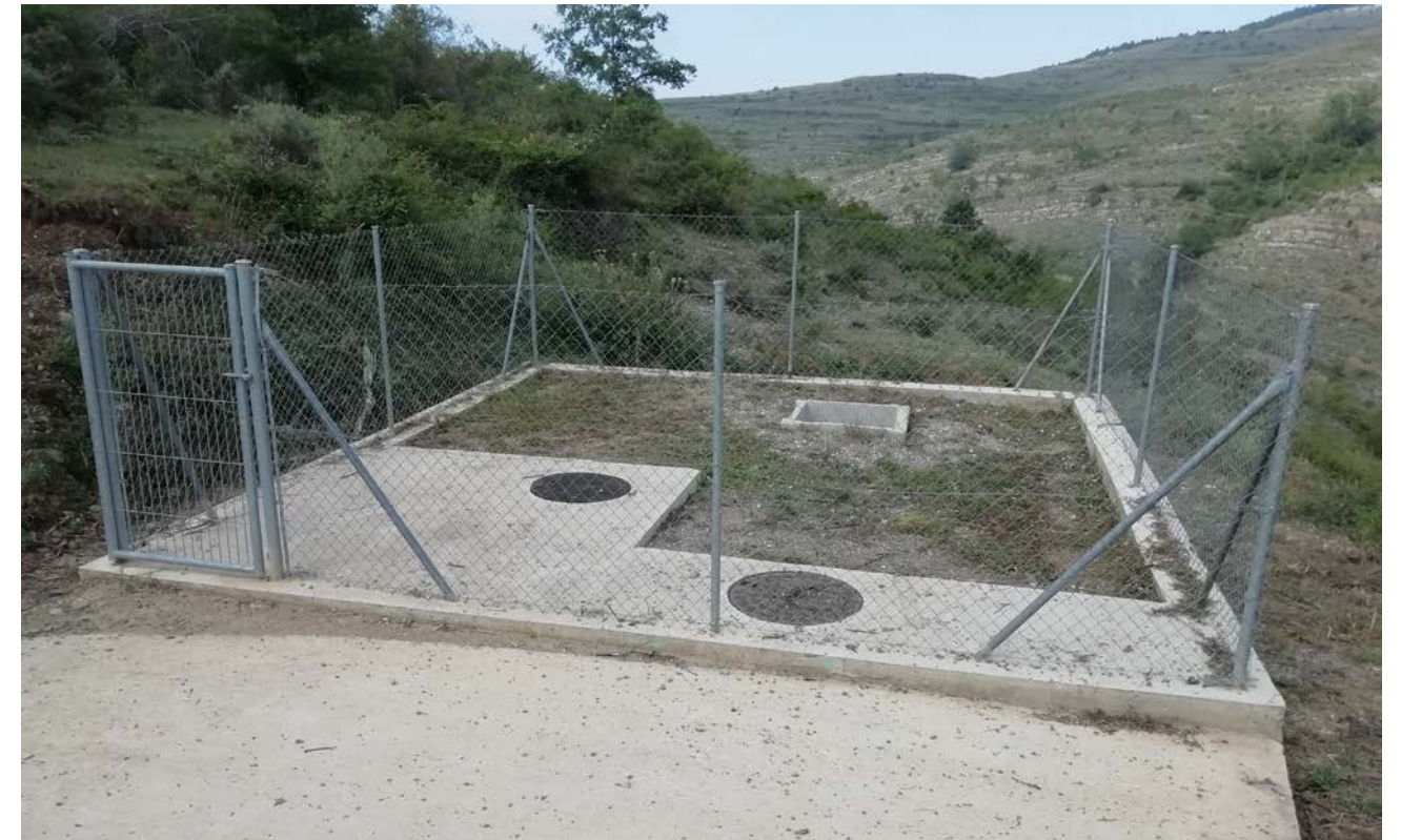
FOTO 1 VALLADO Y 3 REGISTROS: ARQUETA DE LLEGADA, DECANTADOR Y DIGESTOR
