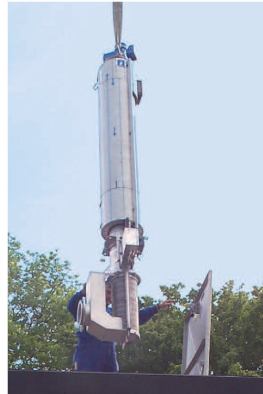
Colocación de un tamiz vertical ROTAMAT® RoK4 en el interior de un pozo de bombeo.
