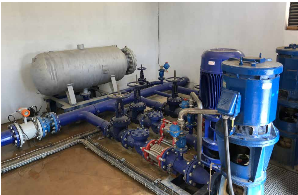
Las bombas funcionan con la energía solar para impulsar hasta una balsa elevada el agua captada en el canal de Lodosa. /Rubén Alcázar (IMEL)
