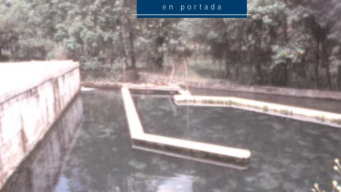
Balsa de decantación, donde queda depositada la materia orgánica que generan las truchas.
