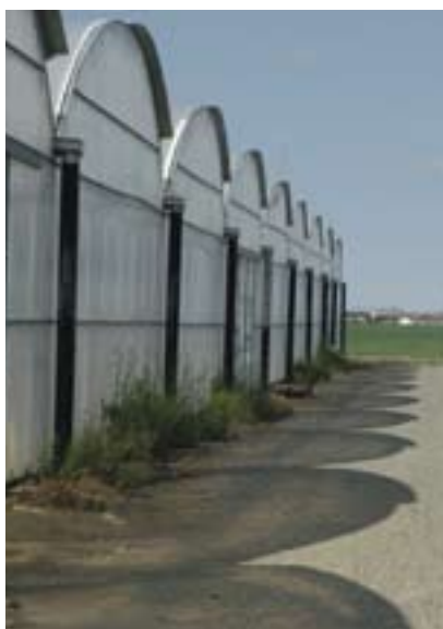
Instalaciones de tipo multitúnel.
