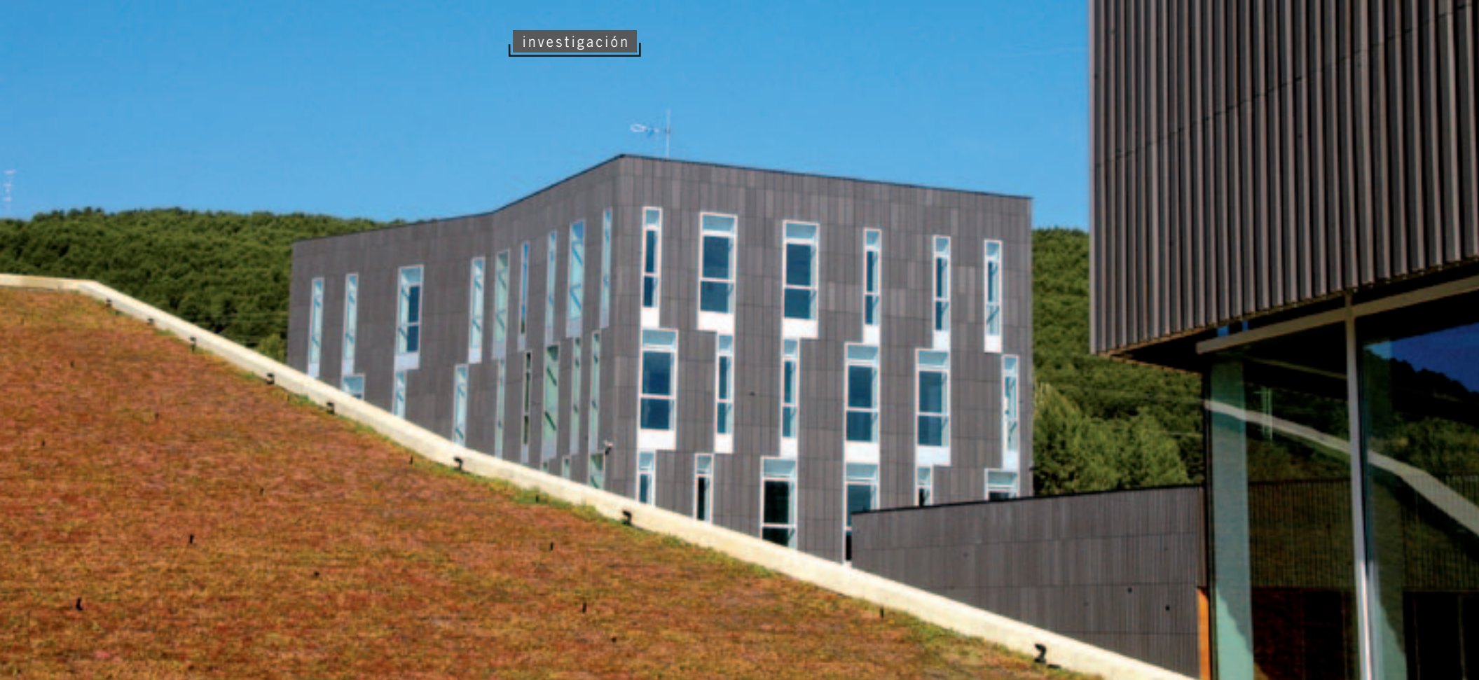
En primer plano se puede ver la cubierta vegetal en la techumbre de la bodega. Al fondo, el edificio administrativo.
