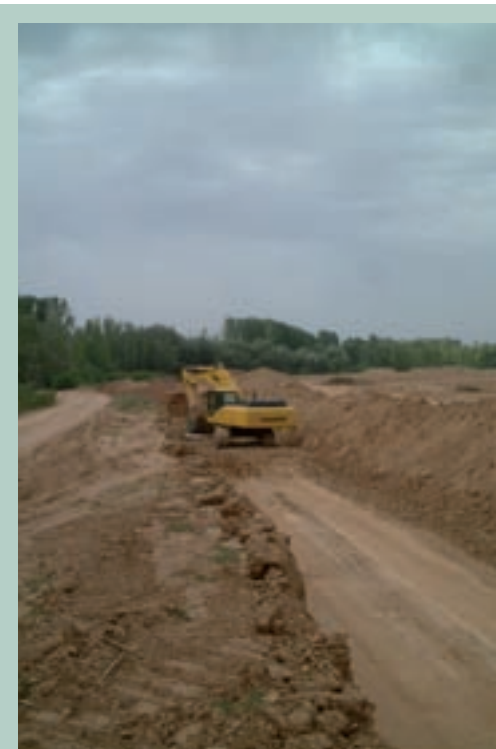
Descubierta del terreno y retirada selectiva de las capas vegetal y de los estériles inertes
