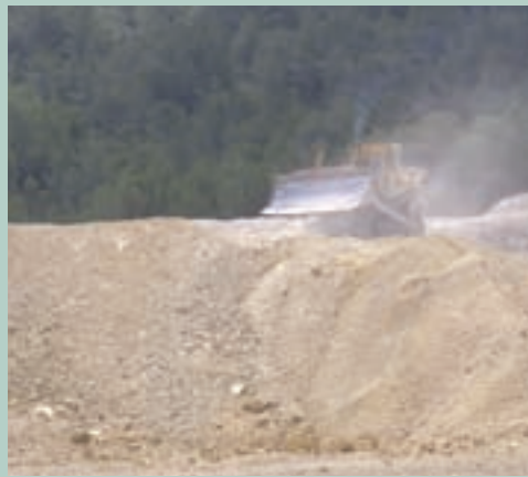
Trabajos con buldózer
