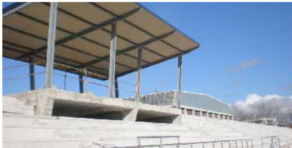
■ Gradas del CTD Adarra. En primer término se aprecian las obras de la caseta video - finish
