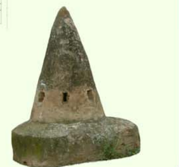
Respiradero de una de las bodegas para evacuar los gases tóxicos que se producen en la fermentación del vino, elegido como emblema del parque
