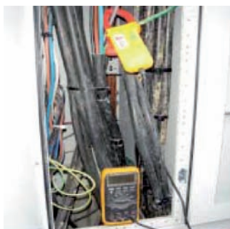
Pinzas amperimétricas conectadas a polímetro
