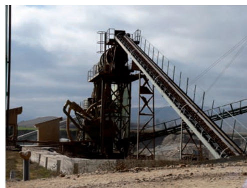
Detalle de una instalación de áridos
