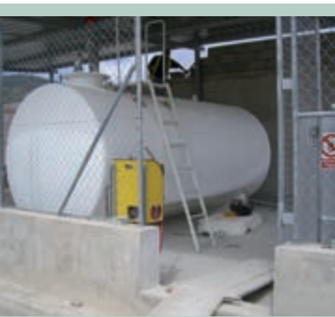
Montaje de un depósito con cubeta de hormigón contra los derrames
