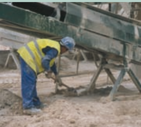
Limpieza de derrames de material
