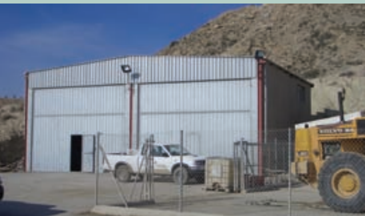
Nave-taller con zona de almacenamiento de residuos y procedimiento para su gestión sistemática
