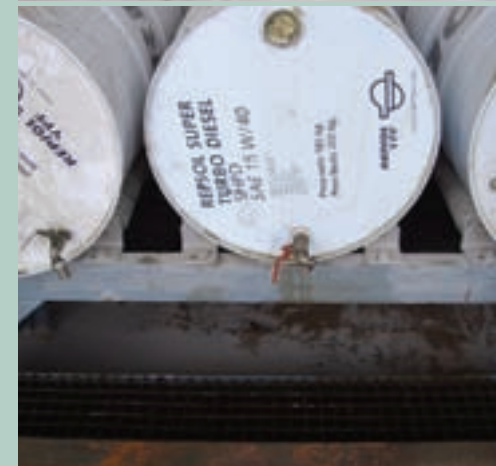
Zona de almacenaje y uso de productos peligrosos, con medidas contra derrames: mejora el orden y la limpieza en la zona de taller y el control y uso de estos productos
