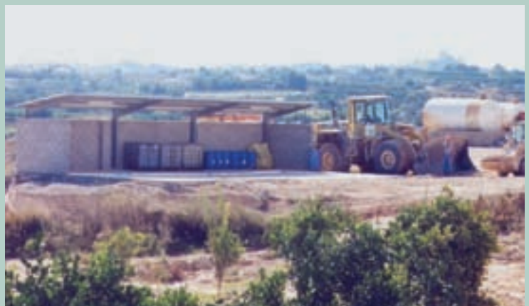
Punto limpio para el almacenamiento selectivo y temporal de residuos, antes de la recogida posterior por un gestor de residuos autorizado
