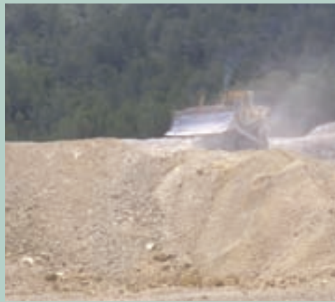
Trabajos con buldózer
