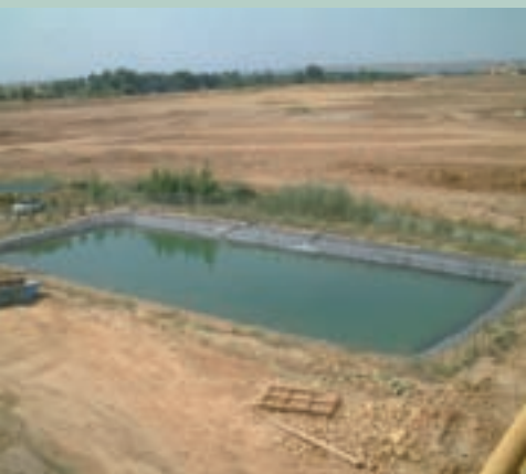
Balsa de recirculación de agua
