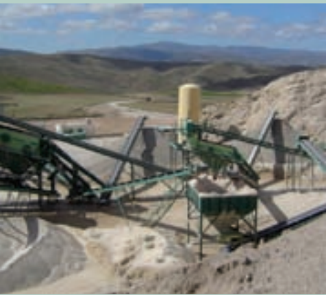
Planta de tratamiento de áridos
