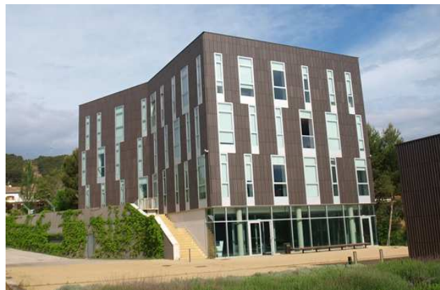
Edificio administrativo del ICVV (Sección de Protección de Cultivos).
